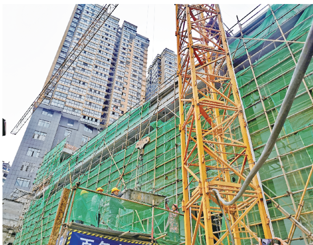
12月10日，白河县城停车场（龙井井停车场）施工现场一片繁忙景象，工人们正在卸料平台开展施工作业。该项目建筑面积10000平方米，属地下三层的停车场，新增私家车位250个，预计明年5月投入使用，将解决周边居民停车难、买菜难问题，为市民带来更多便利和舒适。
