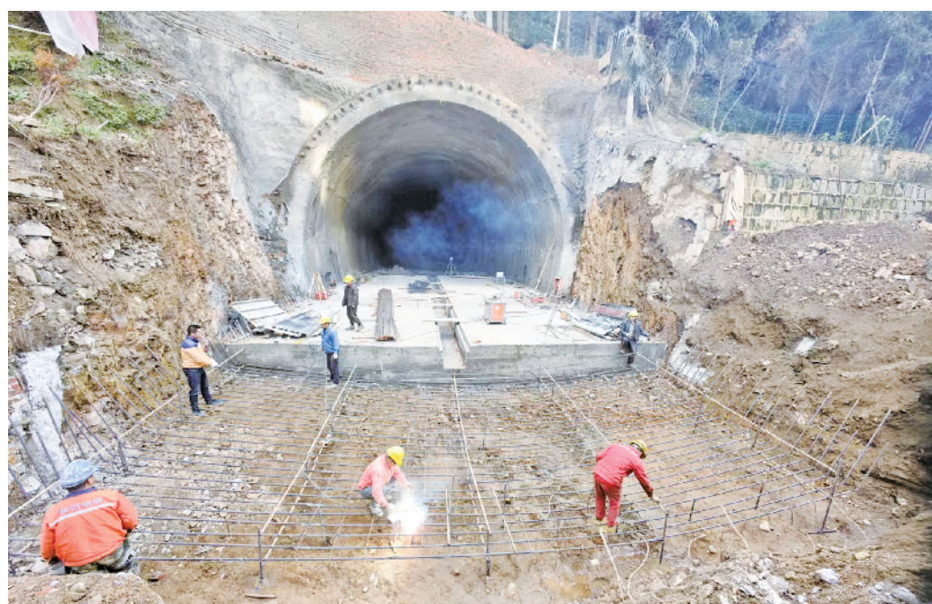
12月9日，在宁陕县东河片区公路项目施工现场，工人们正在有序进行隧道建设。据了解，该项目计划投资2500万元，修建道路全长1403米。项目建成后，将有效解决东河片区群众出行难问题。
