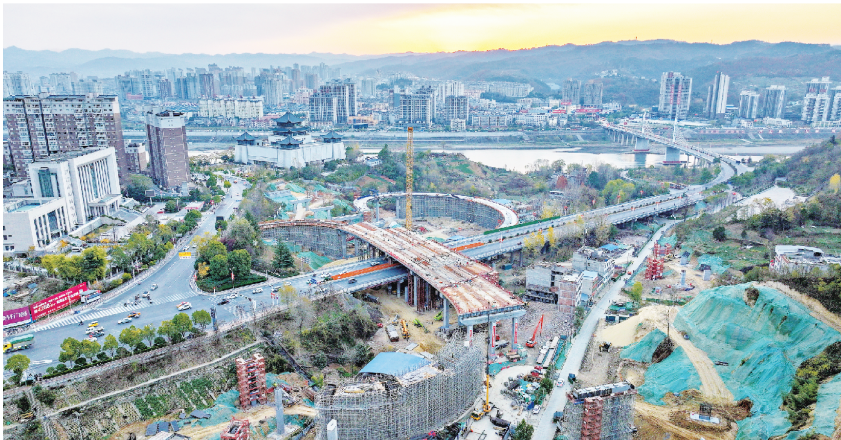
12月14日清晨，建设中的安康市七里沟立交项目施工现场一派忙碌，工程项目正在安全、有序、高效推进中。
