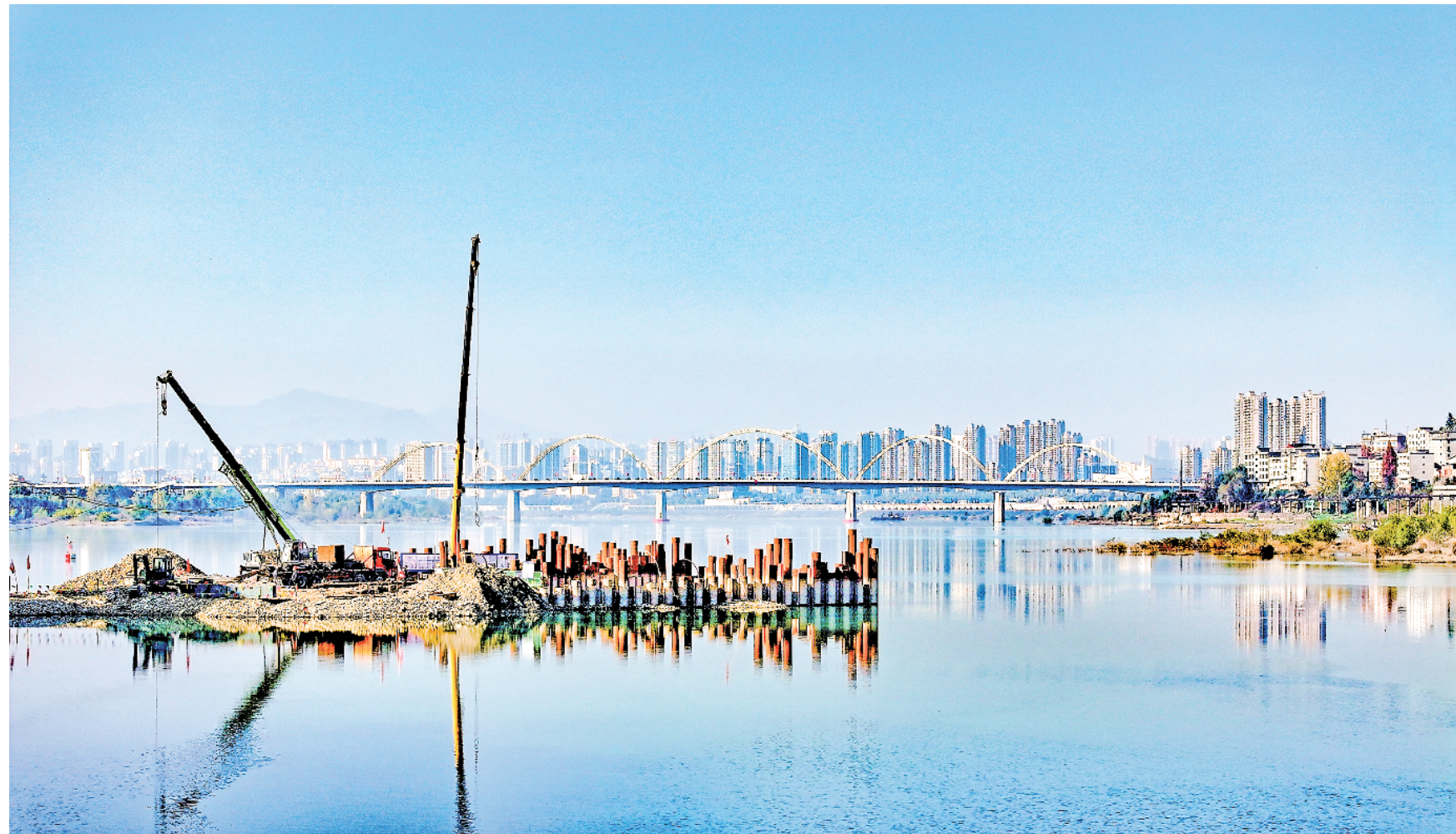
新关庙汉江大桥抢抓冬季枯水施工黄金期，加快大桥主河槽14号墩施工，计划2025年汛期前完成14号墩下部结构。目前，采取的是筑岛围堰施工措施，完成左幅承台浇筑，右幅承台正在进行钢筋绑扎。
