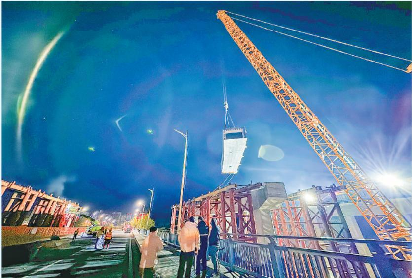
11月26日零点左右,七里沟立交主线钢箱梁第一根架设。
