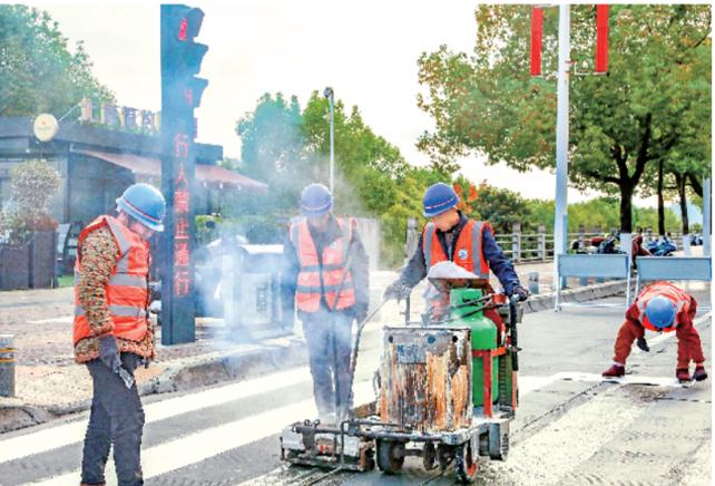
为推进安康中心城区道路精细化管理,保障市民安全出行,11月21日,市政园林工人抢抓晴好天气,采用热熔标线设备对汉城东街模糊、脱落的标线进行提升,施划后的标线整洁清晰、醒目美观。 钱运立 摄
