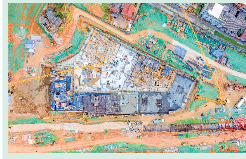
在汉阴县西城(西坛)棚改项目施工现场,塔吊林立、机器轰鸣,施工人员正在赶工期、抓进度、抢时间、保节点,加快推进重大项目建设,确保圆满完成全年目标任务。 王磊 刘东 摄
