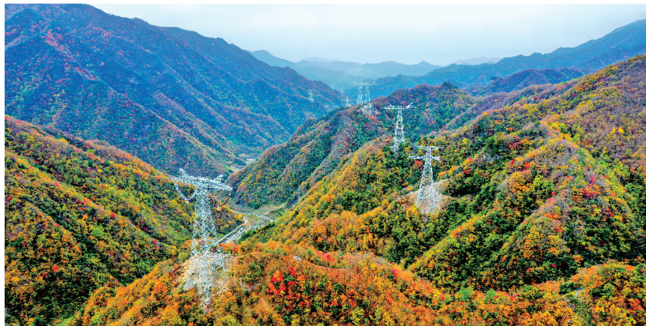
近日,“宁电入湘”工程平利县正阳镇过境塔基建设如火如荼。据悉,“宁电入湘”工程是宁夏至湖南特高压直流输电工程,是以开发沙漠光伏大基地,送新能源为主的特高压输电通道,已纳入国家“十四五”电力发展规划,成为9条跨省跨区输电通道重点工程之一,途经宁夏、甘肃、陕西、重庆、湖北、湖南等省市,线路全长1467千米。 詹永柱 摄
