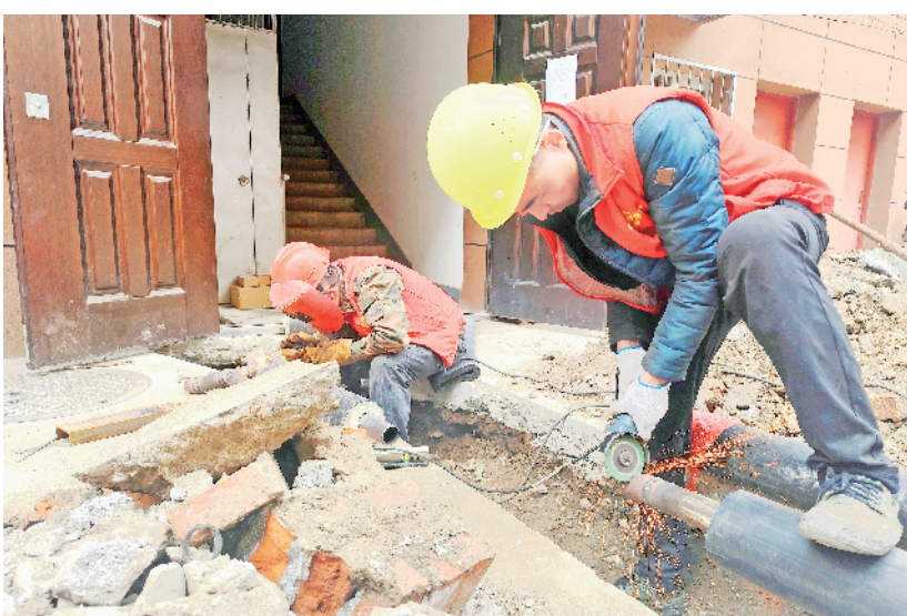
连日来,宁陕县对全县7处供热站、5000米主管网进行排查、检修。目前已完成设备保养、主管道注水、排气及冷循环等工作,并将陆续启动供暖设备。王辉 摄
