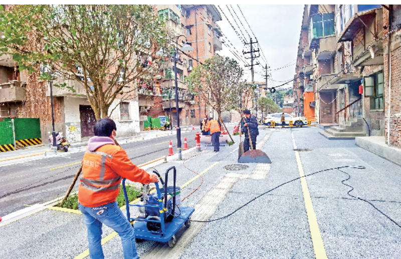
安康中心城区兴安小区主通道市政基础设施改造有序推进,该工程全长约300米,目前已初步完成道路、排水、照明、环卫及配套设施建设。图为10月30日,工人们正在现场施工。 陈德模 摄
