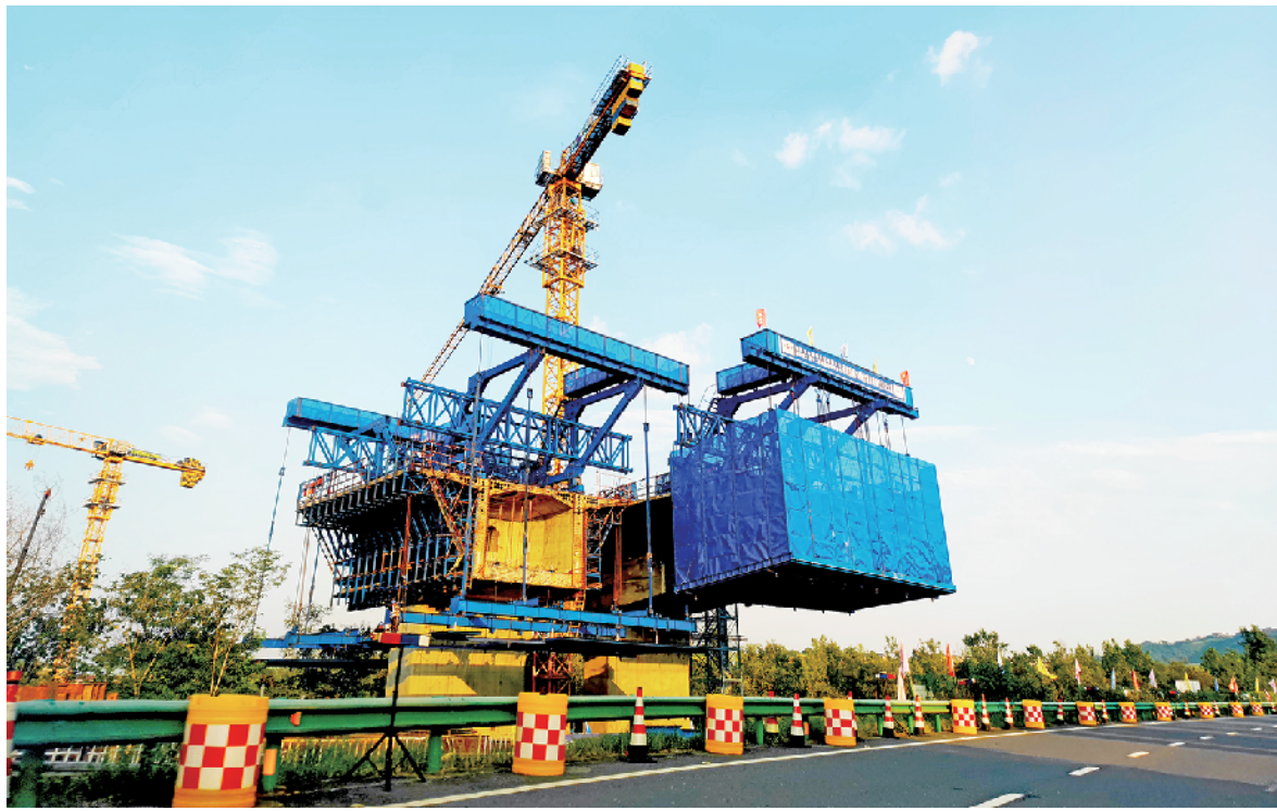
十天高速安康段的市级重点交通项目国道316改建项目宋家营月河大桥,近期正在加速施工,承建方即将完成十天高速主跨梁建设。
