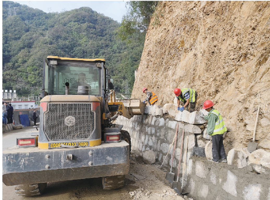
宁陕县排水设施建设(关铁路改造)项目施工现场,施工人员正在抢抓施工进度。项目建成后,将进一步改善群众出行条件,缓解交通压力,方便周边群众的生产生活。
