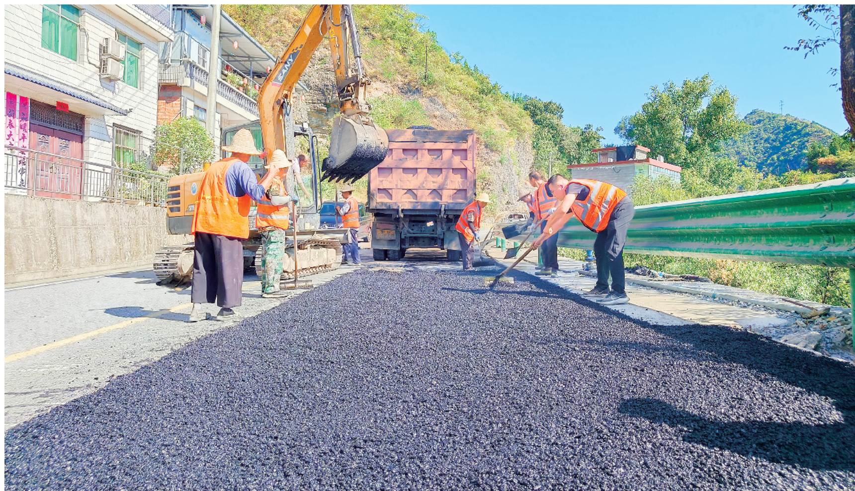
旬阳公路段利用近期晴好天气，对国道316线旬白公路进行路面病害处理修复，挖除破损沥青路面，重新铺筑热沥青碾压成型。本次施工出动机械8台次，共修补坑槽300余平方米。 陈心宏 摄
