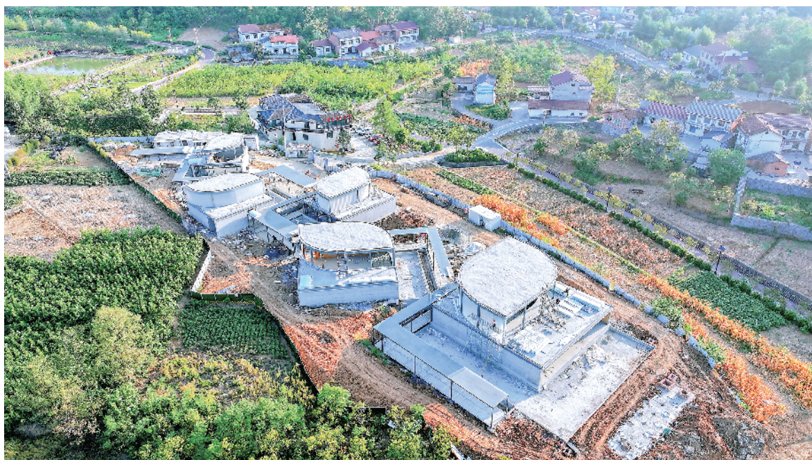
位于石泉县池河镇明星村的蚕桑工坊项目总占地2000余平方米，建筑面积1300平方米，包括蚕文化馆1座、大小蚕共育室1座、研学教室1座、手工作坊1座等，同时配套完善道路、停车场、给排水、供电、绿化、亮化等基础设施，目前项目总体施工进度已完成90%以上，全部建成后，将进一步提升沧浪桑田景区研学旅行服务质量和水平。 许兵 摄
