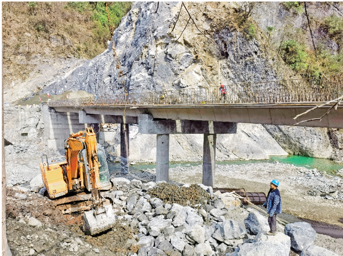
今年以来，平利县正阳镇渡正路改建工程项目抢抓工期、全力推进，确保项目按时完成建设。 黄小彬 摄
