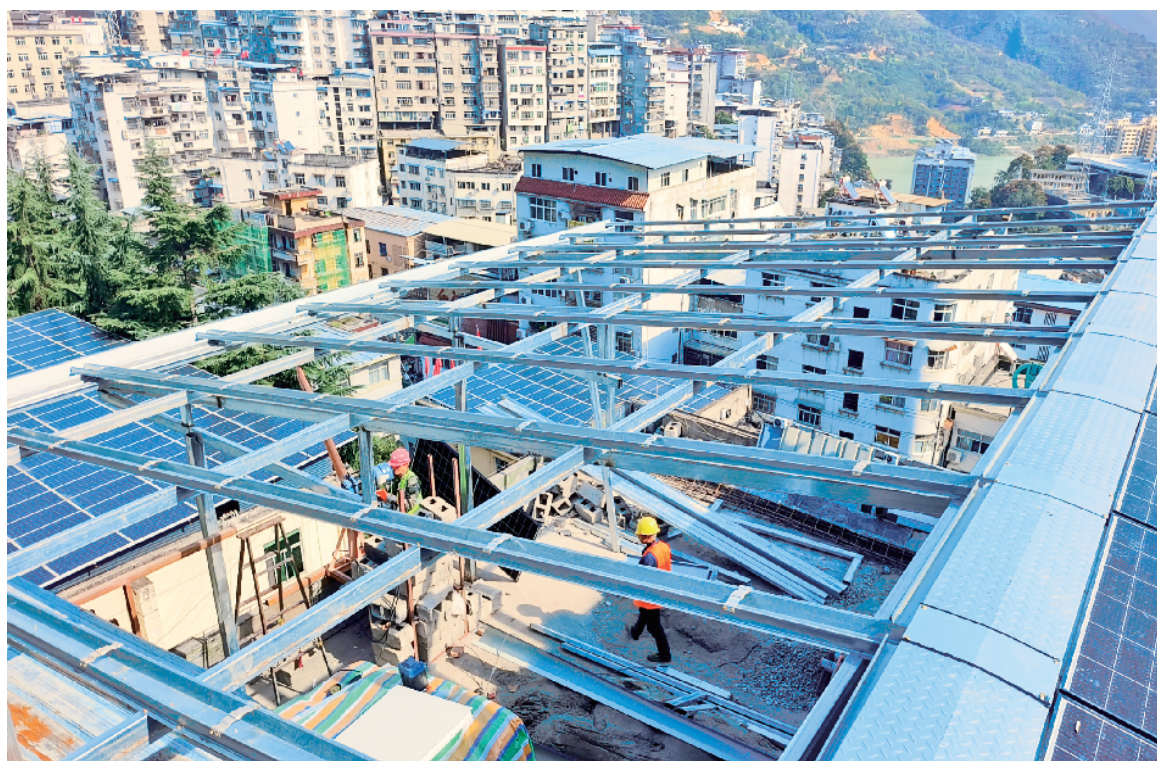
安康富硒食药产品产业园位于白河县卡子镇大桥社区，是市级重点项目，目前已完成二期厂房、综合办公楼、跨河大桥等主体建设，正在筹备三期厂房建设，确保推进红豆杉、虎杖等中药材和特色农产品富硒食药产品生产加工项目及早启动。 刘静 摄
