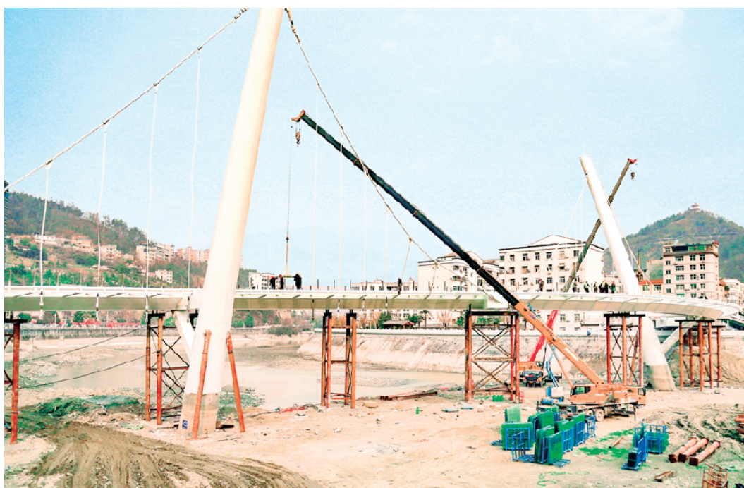
一月二日，岚皋县城岚河人行桥项目施工现场，工人们正在加紧施工，确保工程有序推进。据悉，岚河人行桥路线全长1.2公里，主桥长度100米，主桥总宽度60米，桥面两侧各设置1米宽的玻璃步道和0.5米宽的护栏，中间为1米宽的玻璃桥面。廖霖 摄
