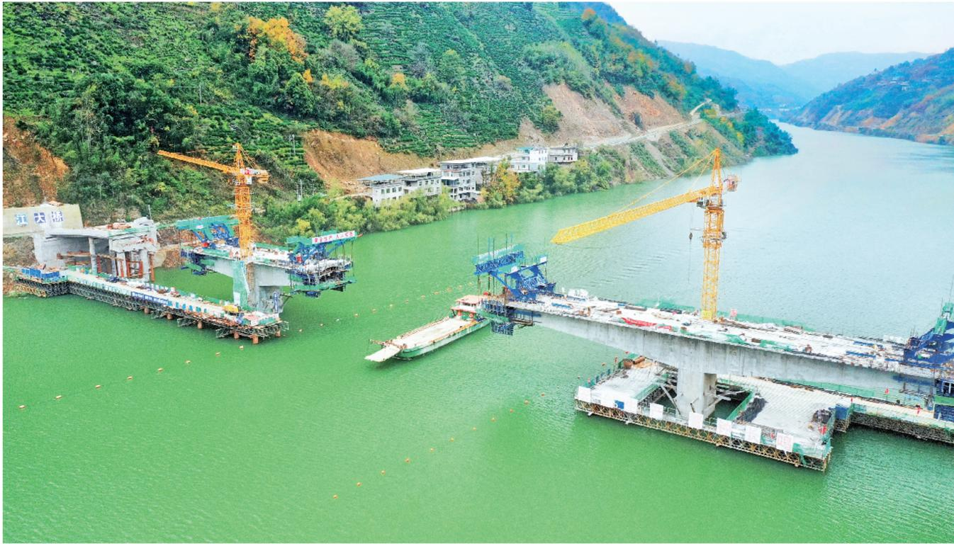
连日来，工程施工人员抢抓有利天气，加快国道541紫阳段和平汉江大桥建设工作。据悉，紫阳和平汉江大桥全长235米，目前下部结构工程已全面完成，预计2023年4月可正式合龙通车，届时国道541紫阳段将全面完工。
