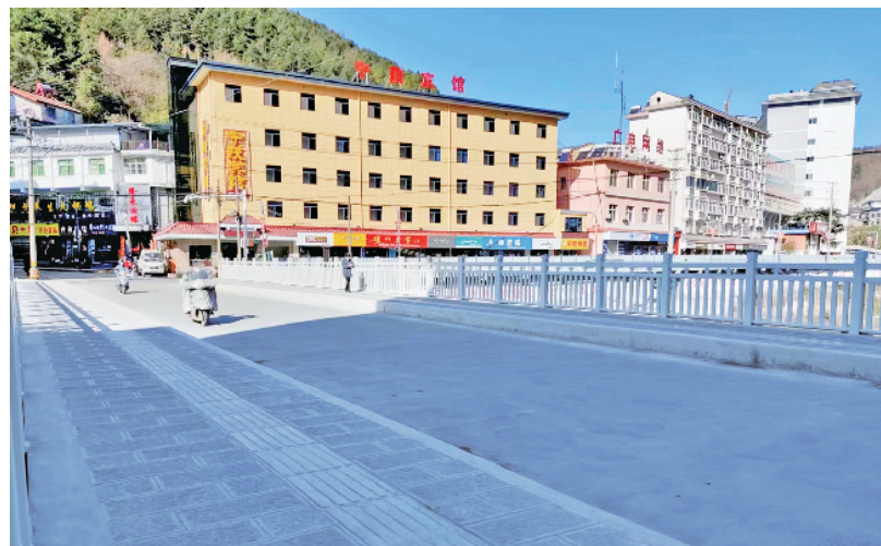
提升改造完成后的迎宾桥
