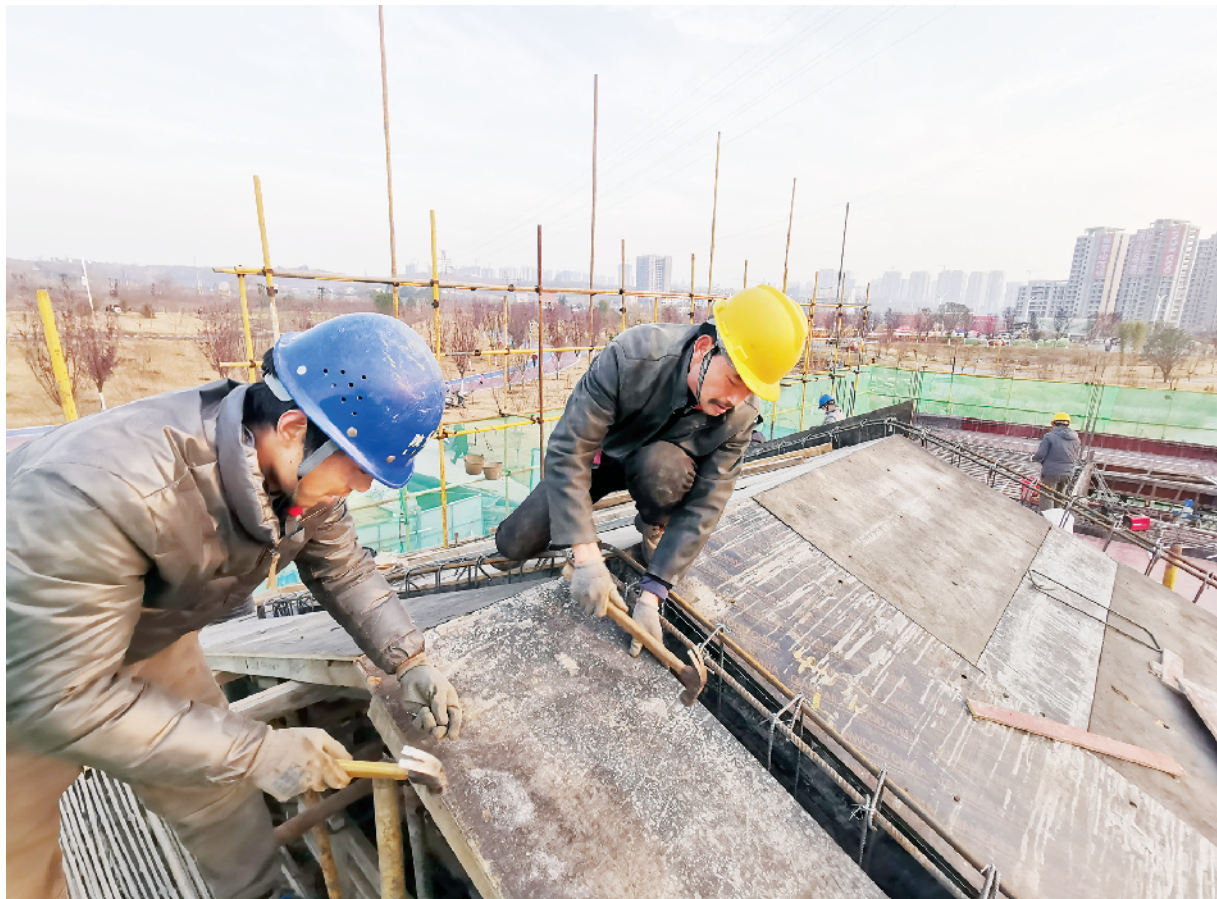
12月28日,安康高新区桃花源生态公园A区商业建筑正在加紧施工。据工程现场负责人介绍,目前正在建设的是1期项目,该项目预计在2023年春节前完成主体建设。这里还将规划茶吧、书吧、超市和小吃一条街。
