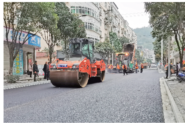
在市政道路“白改黑”工程中，工人们驾驶压路机在沥青路面施工。
