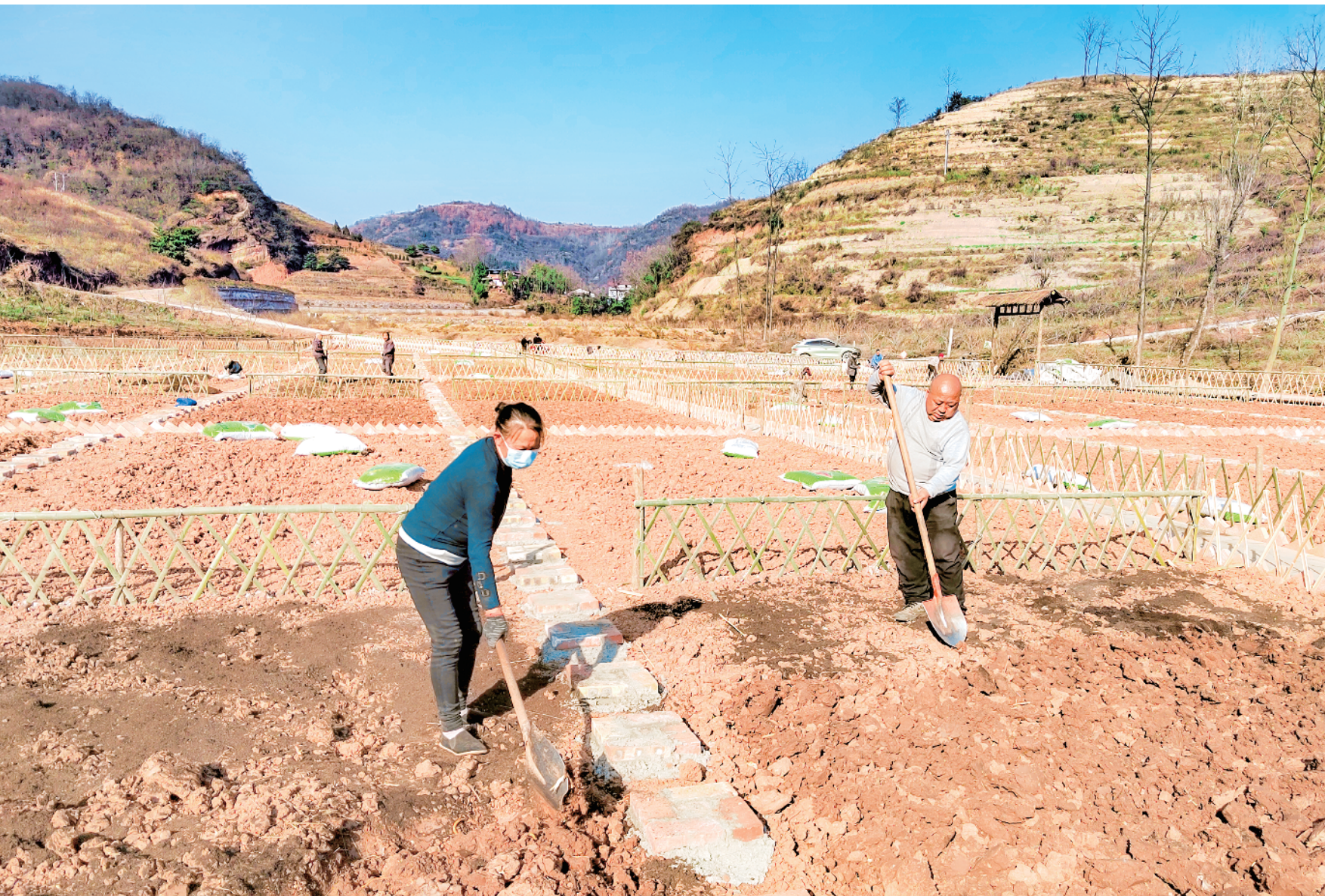
走进汉阴县城关镇前进村高标准农田项目建设现场,村民们忙着平整土地、铺设管道、维修机耕道、疏浚沟渠,到处是一片繁忙的景象。近日,汉阴县城关镇21个行政村抢抓农时推进高标准农田建设项目,通过连片整地,形成“田不荒、渠相通、路相连”的田园风光。
