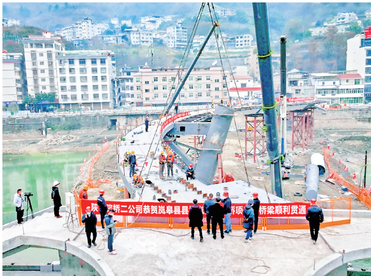
12月20日，岚皋县城炭河人行桥项目实现钢桥梁顺利贯通，桥梁主体基本完工。该项目于今年5月下旬开工，目前项目已完成总量86%，后续将完成桥梁缆索、桥面铺装和玻璃步道等施工，预计2023年1月15日具备通行条件。周煜 周威 摄
