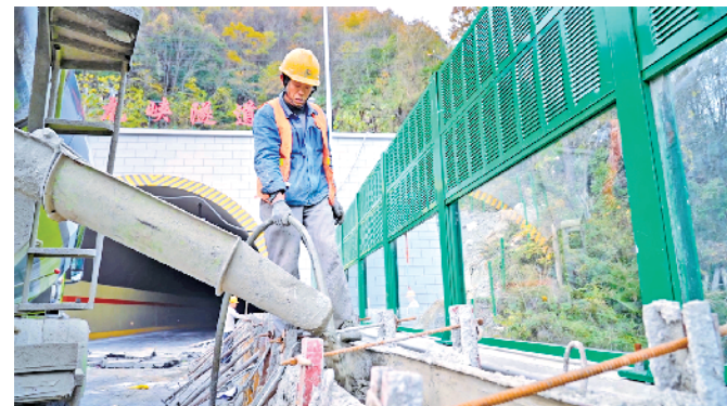
工人正在进行护栏浇筑 张凤奇 摄
