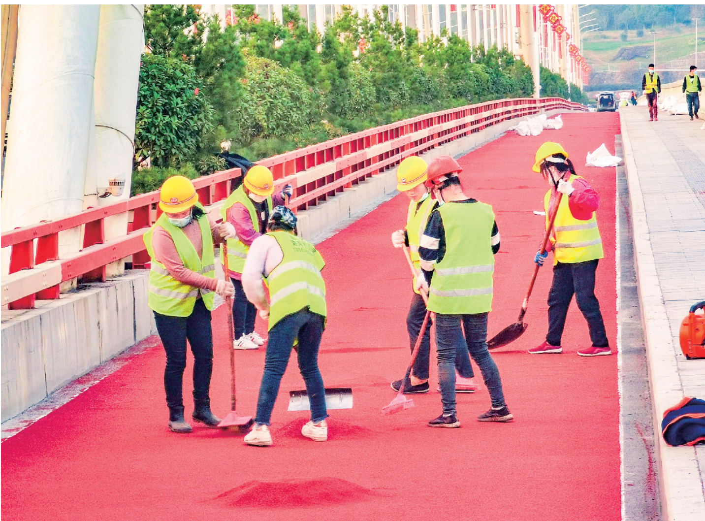
11月20日,安康城区江北滨江健身长廊项目正在东坝大桥桥面施工。该项目主要包括一条骑行道和一条健身步道,其中健身步道路面为蓝色,长达6千米;骑行道路面为红色,长达14.31千米,均为陶瓷颗粒防滑路面。
