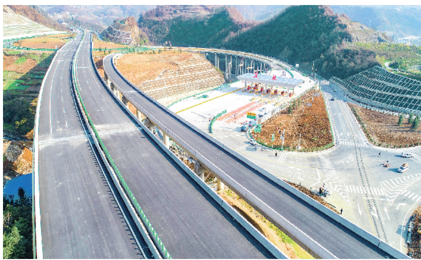
安岚高速公路岚皋互通式立交。
