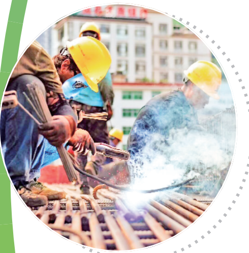
工人正在焊接县城一桥桥面钢筋构架。
