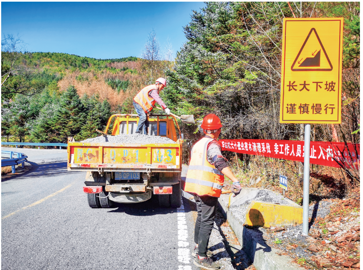
岚皋公路段提前储备冬季除雪防滑保畅物资,对国道108公路平利县八仙镇化龙山路段补充防滑料。
