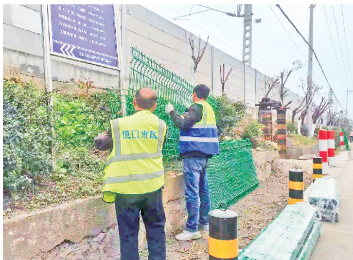
恒口示范区工作人员加装道路隔离网。
