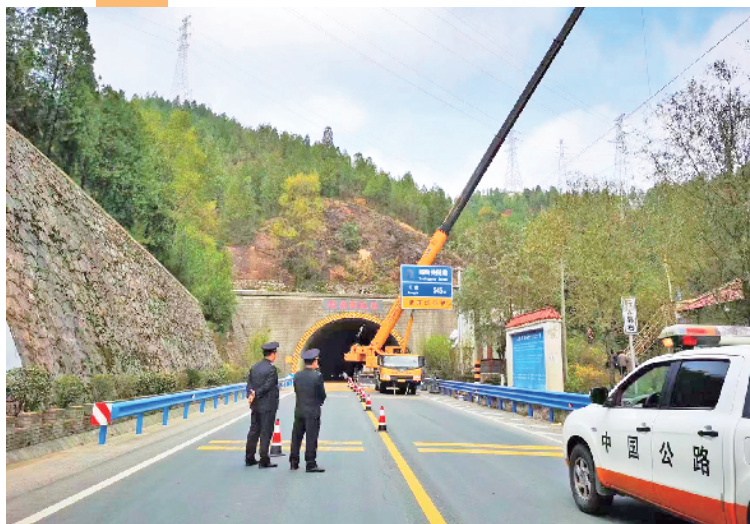
恒口示范区清理道路两旁杂物。
