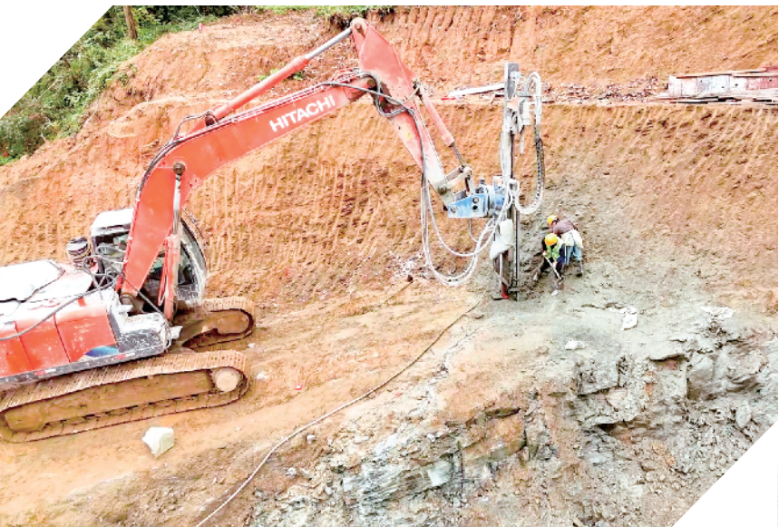
挖掘机正在作业
