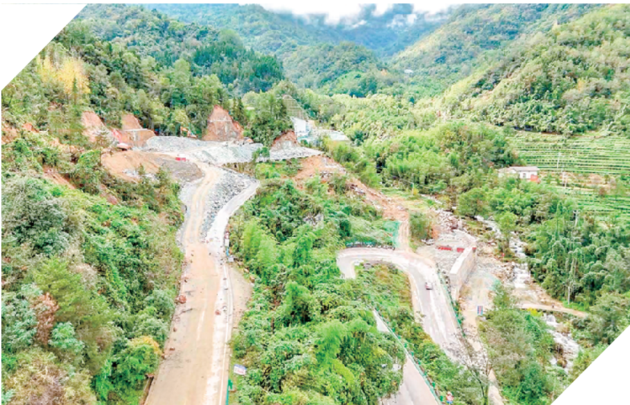
凤凰山隧道引线工程(进口段)
