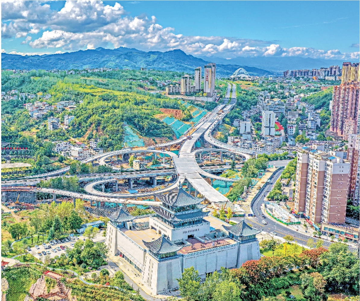
10月13日,安康城区七里沟立交项目抢抓雨后天晴时机,抓紧施工,目前立交雏形已基本形成。
