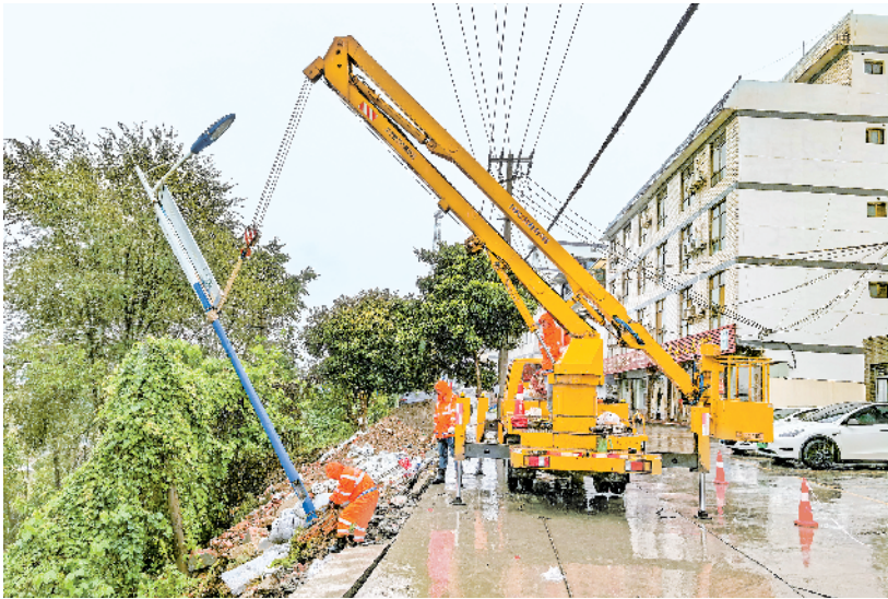
10月12日，安康中心城区桂花巷因山体滑坡致使路灯杆基础移位、灯杆倾斜，安康城市照明应急抢险分队迅速启动应急预案，抢险人员冒雨作业，通过高空作业车等设备对隐患灯杆进行拆除处置，及时排除安全隐患。 钱运立 摄
