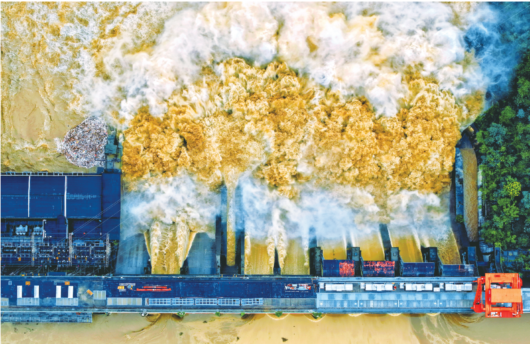
9月19日,石泉水电站开6孔泄洪迎汛。当日石泉水电站入库流量每秒9040立方米,出库流量每秒8000立方米,水库水位404.68米。
