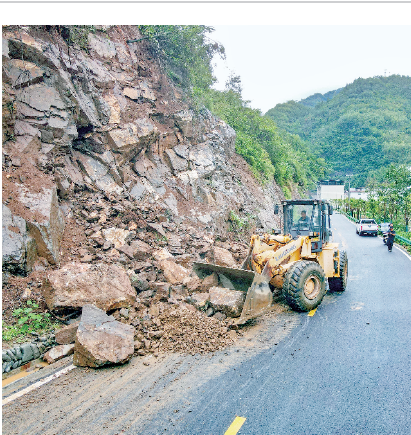
↑ 9月16日以来，紫阳县持续降雨，县乡村公路多处发生塌方泥石流，造成3处交通中断。县交通运输局及县农村公路养护中心调运工程机械进行紧急抢修。
