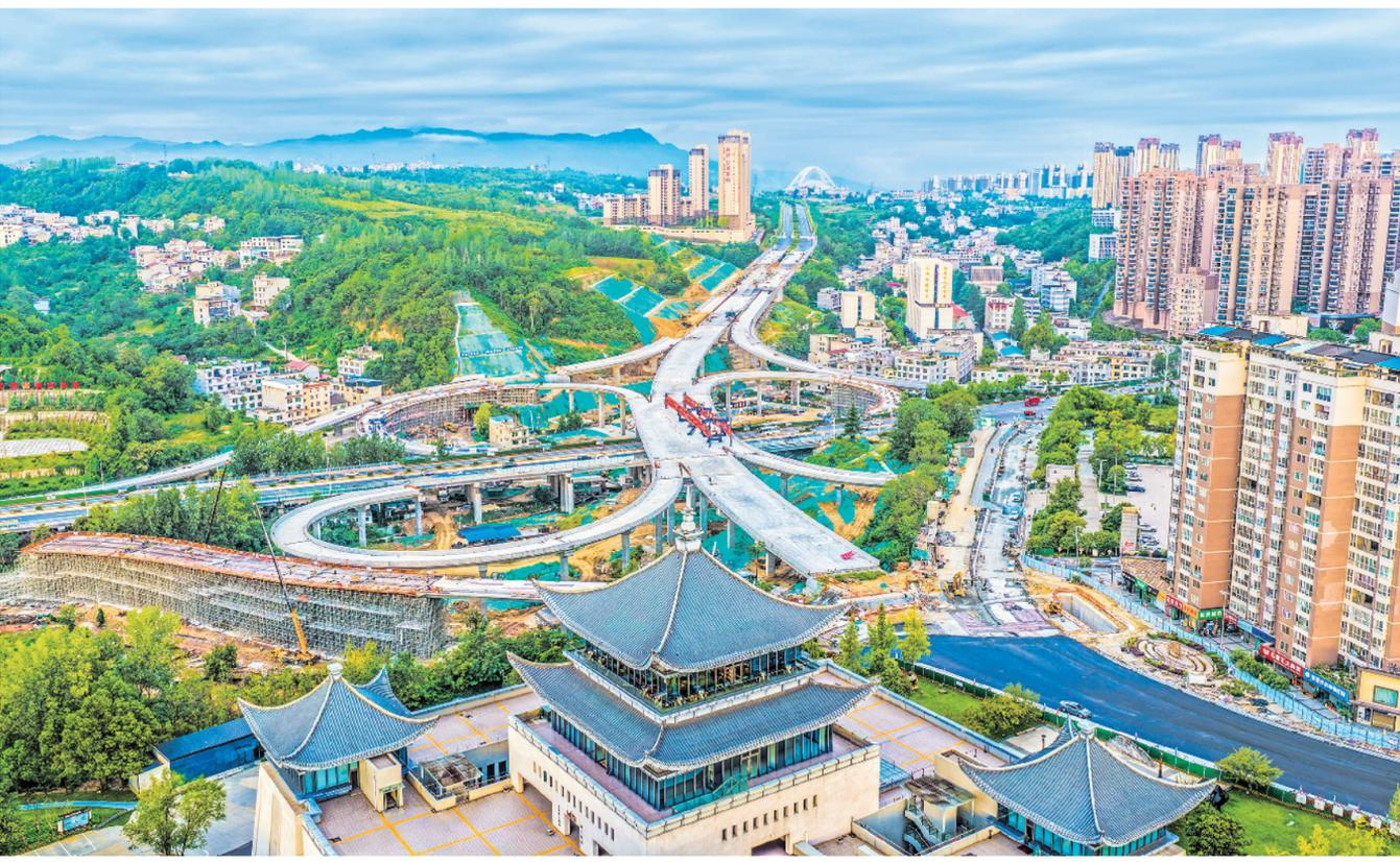
9月15日，安康市中心城区七里沟立交桥项目现场有序施工。据介绍，目前工程整体进度已经过半，全部钢箱梁已经架设完毕，之后会加快推进匝道建设，争取今年年底前完成项目主体建设。张忠 摄
