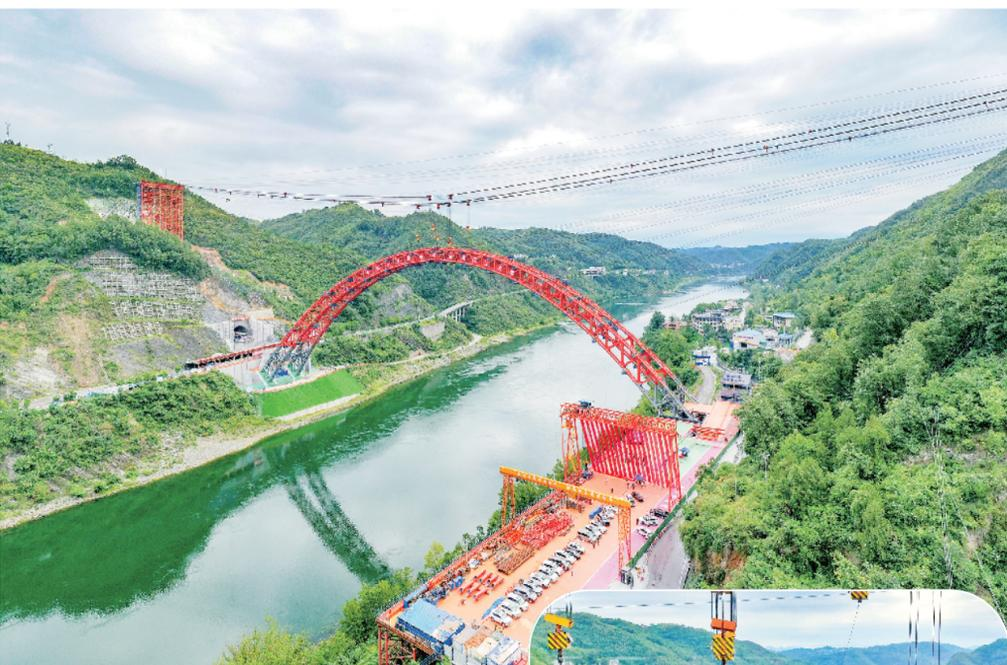
8月28日，西渝高铁安康汉江大桥完成拱桥搭建，这标志着大桥建设进入了新的阶段。据介绍，该大桥是目前国内时速350公里高速铁路单孔跨度最大的中承式钢管混凝土拱桥。
