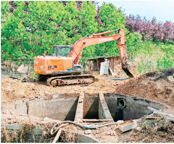
基础设施提质效
