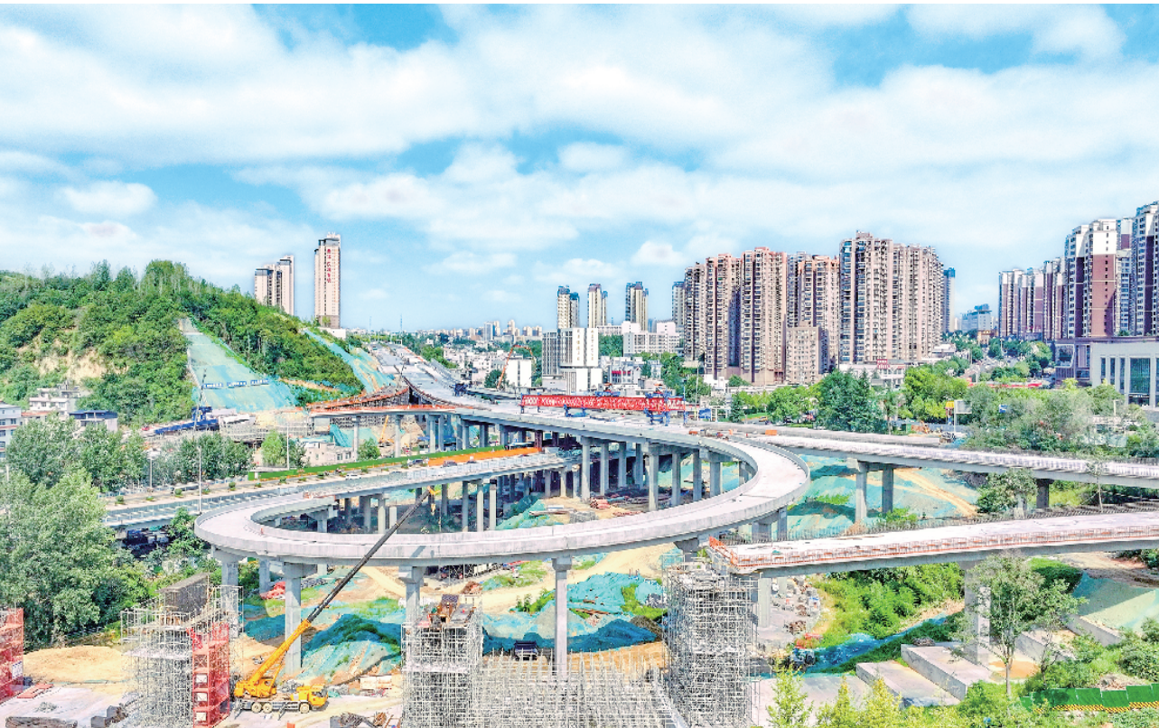
连日来，安康中心城区七里沟立交桥项目建设有序推进。图为 8 月 14 日项目建设现场。
