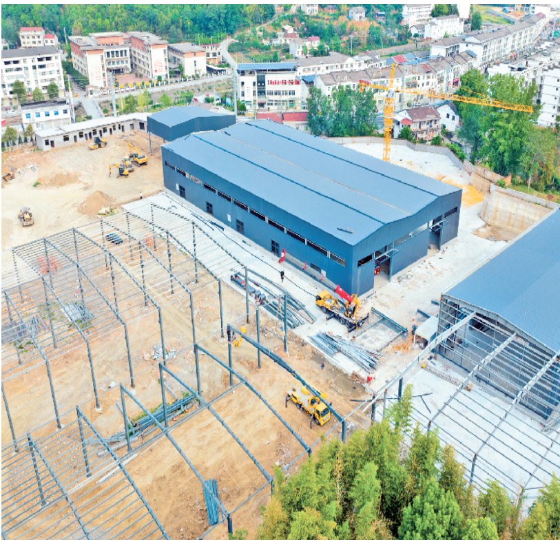
6月13日,石泉县报废机动车资源回收项目迎来建设冲刺期,工人们正使用起重工具安装标准化汽车零件分拣车间厂房,预计7月底完成项目主体建设。该项目总投资5000万元,建成后将在石泉本地形成报废汽车“回收、拆解、分拣、销售”的再生资源循环发展新业态。董长松 摄
