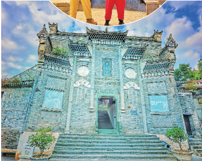
蜀河古镇地标性建筑——黄州会馆
