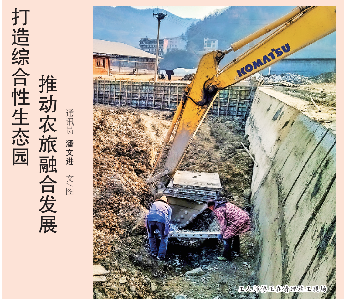
综合性示范园区进行尾期工程施工
