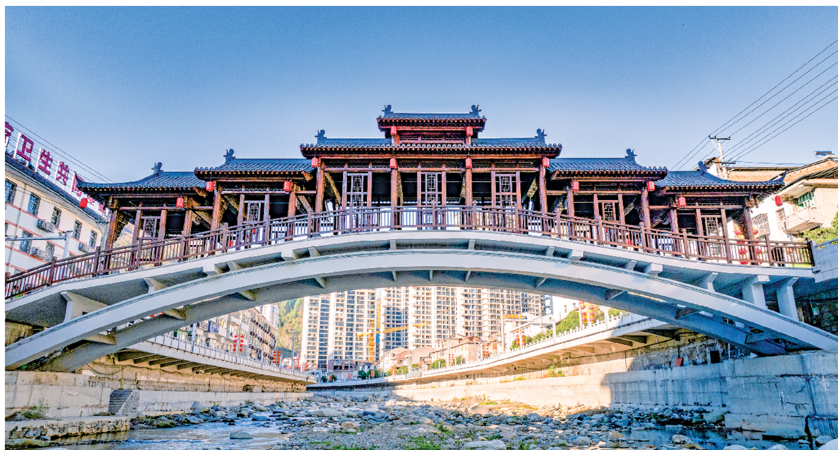
宁陕县健安桥近日完成改造提升并投入使用,成为县城的一个新地标,吸引众多群众游玩打卡。据了解,健安桥改造提升工程是宁陕县10件民生实事项目之一,由宁陕县住建局负责实施,工程包括对桥梁的荷载检测、加固处理、照明亮化,以及在桥梁上增建一座仿古建筑长廊。
