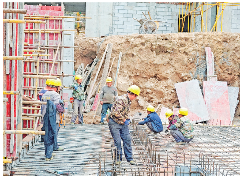
工人抢抓时间铺设钢筋
