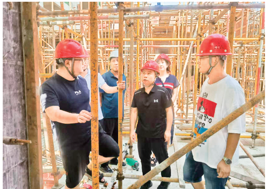
近日,宁陕县住建局以安全生产为底线,以项目推进为核心,以如期完工为目标,组织工作人员深入重点项目一线开展安全生产督导检查,确保项目建设快速平稳推进。图为9月20日,工作人员对宁陕县东河康养综合项目进行安全检查。
