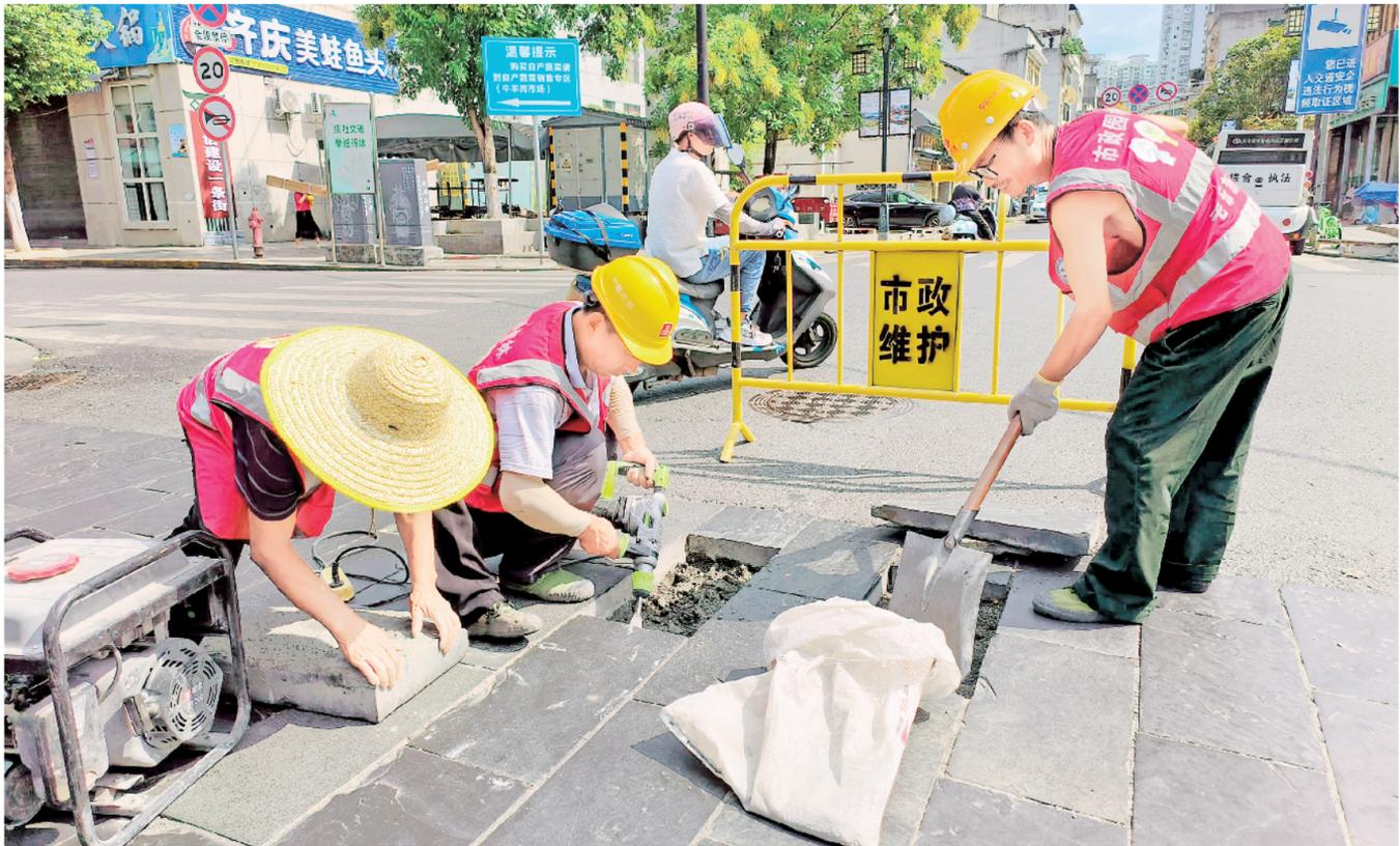
为有效提升道路品质,保障路段畅通运行,近日,市政园林处组织开展中心城区人行道专项整治工作,已完成道路零星坑槽修补170平方米,维修更换人行道砖340平方米,路缘石60米,安装树围12处,更换检查井28座,全力保障群众“脚下安全”。图为兴安路人行道精修维护。钱运立 沈淑萍 摄
