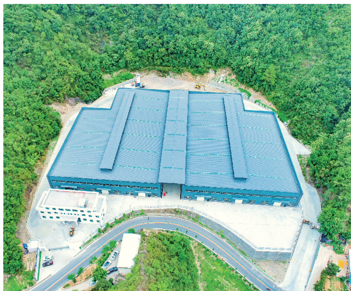
8月下旬,白河县构扒产业园区基础设施建设项目(一期)二区竣工。该项目位于白河县构扒镇东坡村,厂区总建筑面积2万余平方米,主要包括厂房、附属用房及厂区基础配套设施。
