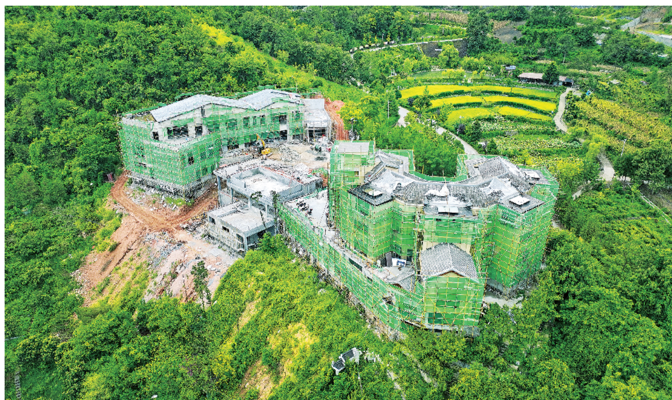
8月26日,市级重点项目石泉县杨春柳园生态度假村项目一期主体工程已建设完成,工人们正加快速度平整和室内装修施工,预计2024年年底正式投入运营。据悉,该项目一期总投资1亿元,建设模块包含吊脚楼、游泳池、冲浪游玩区等,项目建成后将进一步丰富石泉生态旅游资源。 董长松 摄
