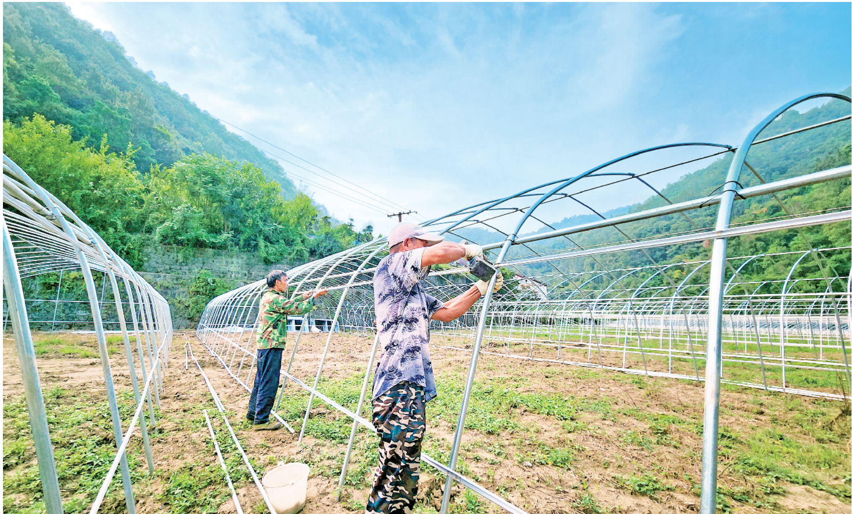
8月26日,石泉县城关镇预制茶种植基地一期项目正加紧建设中,工人们正加快阳光温室搭建及土地改良翻耕,预计10月底完成建设,项目总投资300万元,建成后将有有效延伸预制茶产业链条,扩大就业需求,助力乡村振兴。
