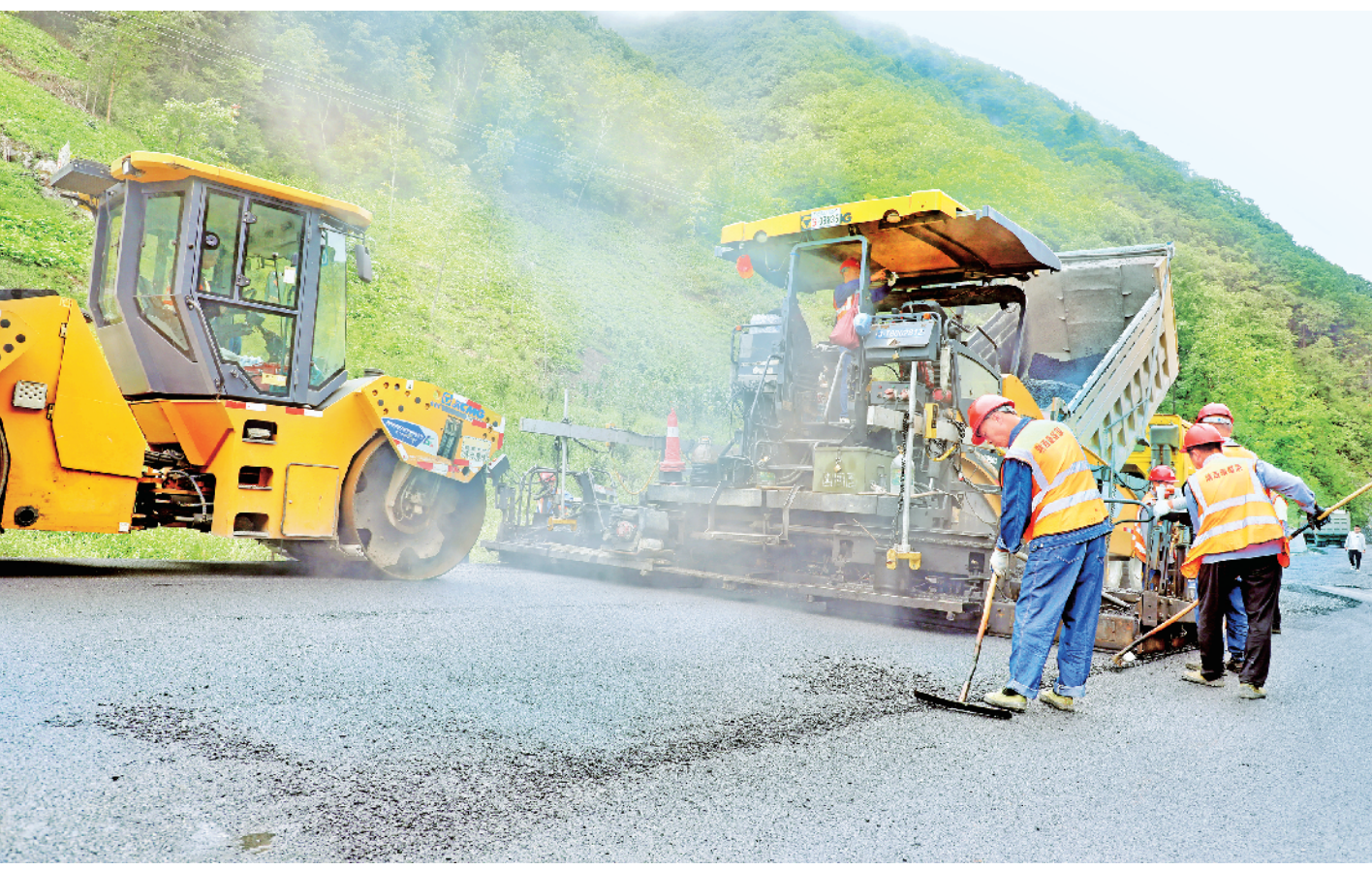
8月27日，工程人员正在平利县渡船口至正阳大草甸公路改建工程施工。据介绍，该项目起于正阳镇渡船口，接国道G541，终于陕渝交界处，顺接重庆市城口县省道501，路线全长36.3公里，总投资2.2亿元，建设工期3年。目前已完成水稳铺设34公里、沥青路面铺设11公里，沿青路路面1.7亿元。道路预计今年“十一”前建成通车，对促进全域旅游发展、巩固拓展脱贫攻坚成果、助推乡村振兴具有重大意义。
