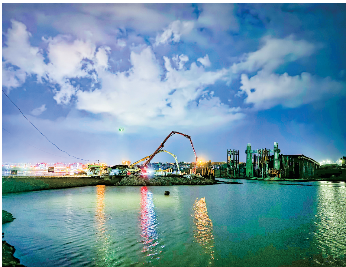
新关庙汉江大桥主塔混凝土浇筑正在紧张进行中。
