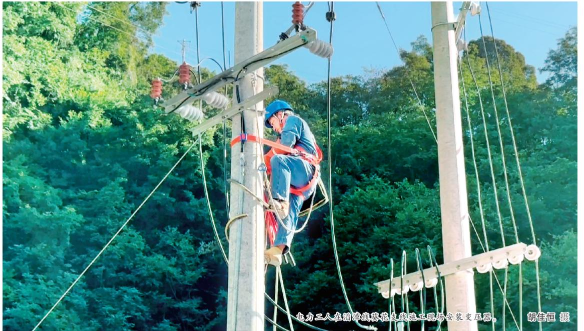
电力工人在滔溪线蔡花支线施工现场安装变压器。
