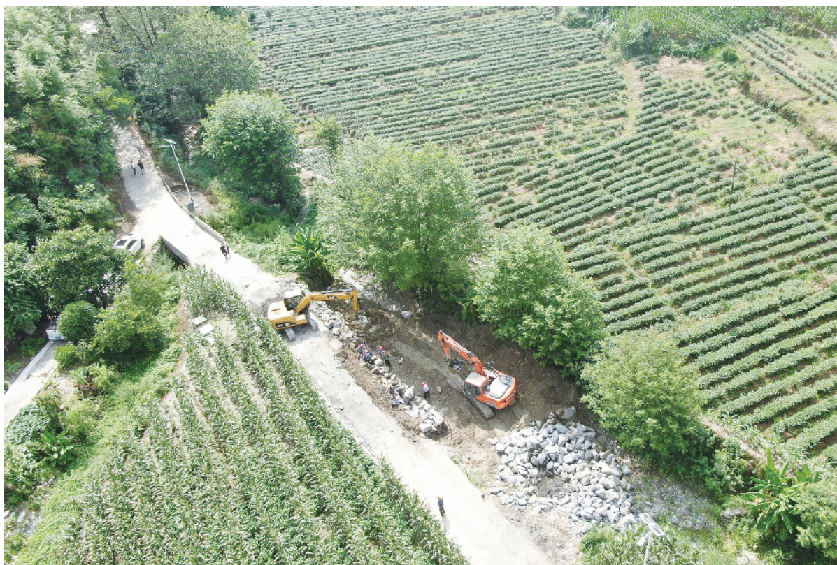
工期,精准发力,确保工程按时按质完成。该工程预计今年10月完工。梅兴宇 摄
