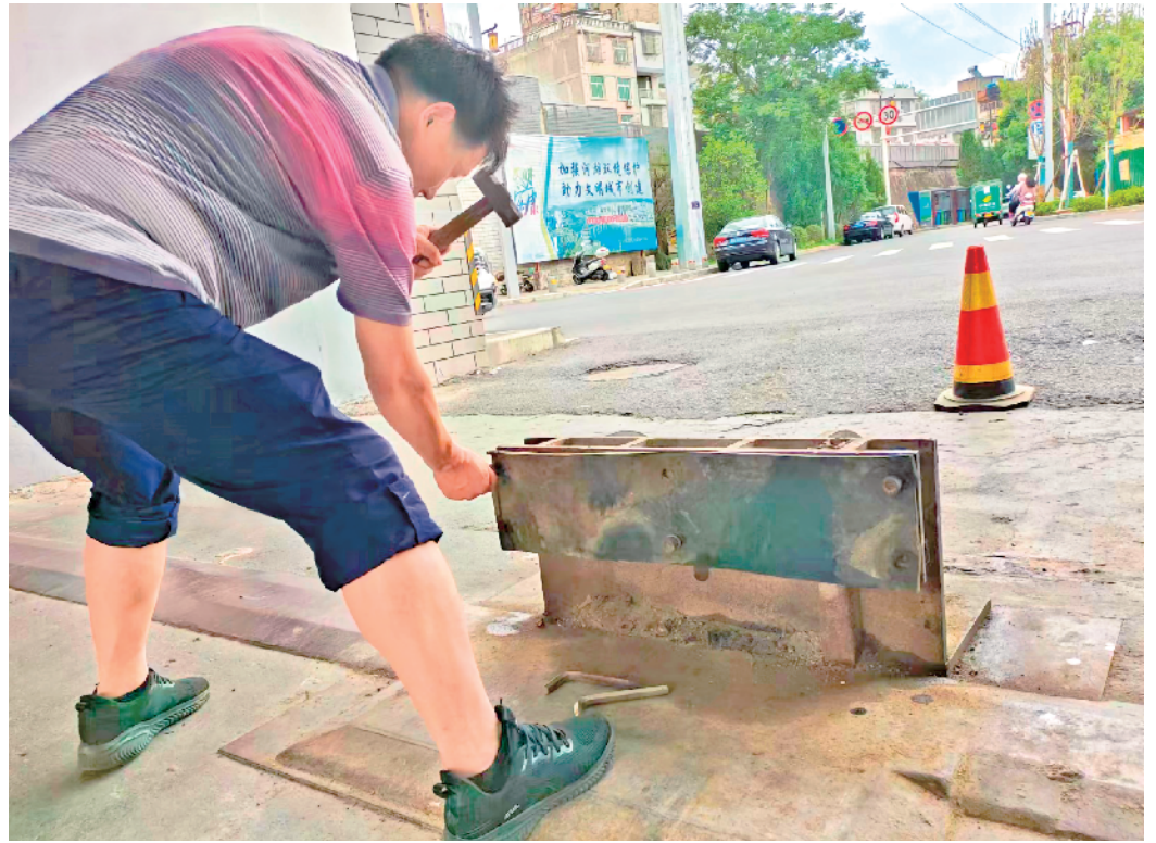
▲7月8日,汉滨区水利局河道堤防管护站对西坝防洪闸门进行维护,按照一闸门一档案对城区9道交通闸门分别建立健康台账,确保闸门工况良好。汉滨区水利局供图
