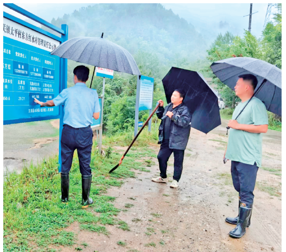
面对严峻的雨情,汉阴县城关镇对辖区各库塘大坝、输水洞、闸门启闭设施等关键部位进行全面排查。图为7月8日,相关责任人在太平村东方红水库进行巡查,确保水库安全。
