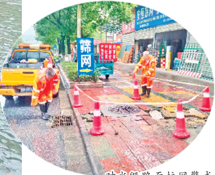
对水毁路面拉网警戒
